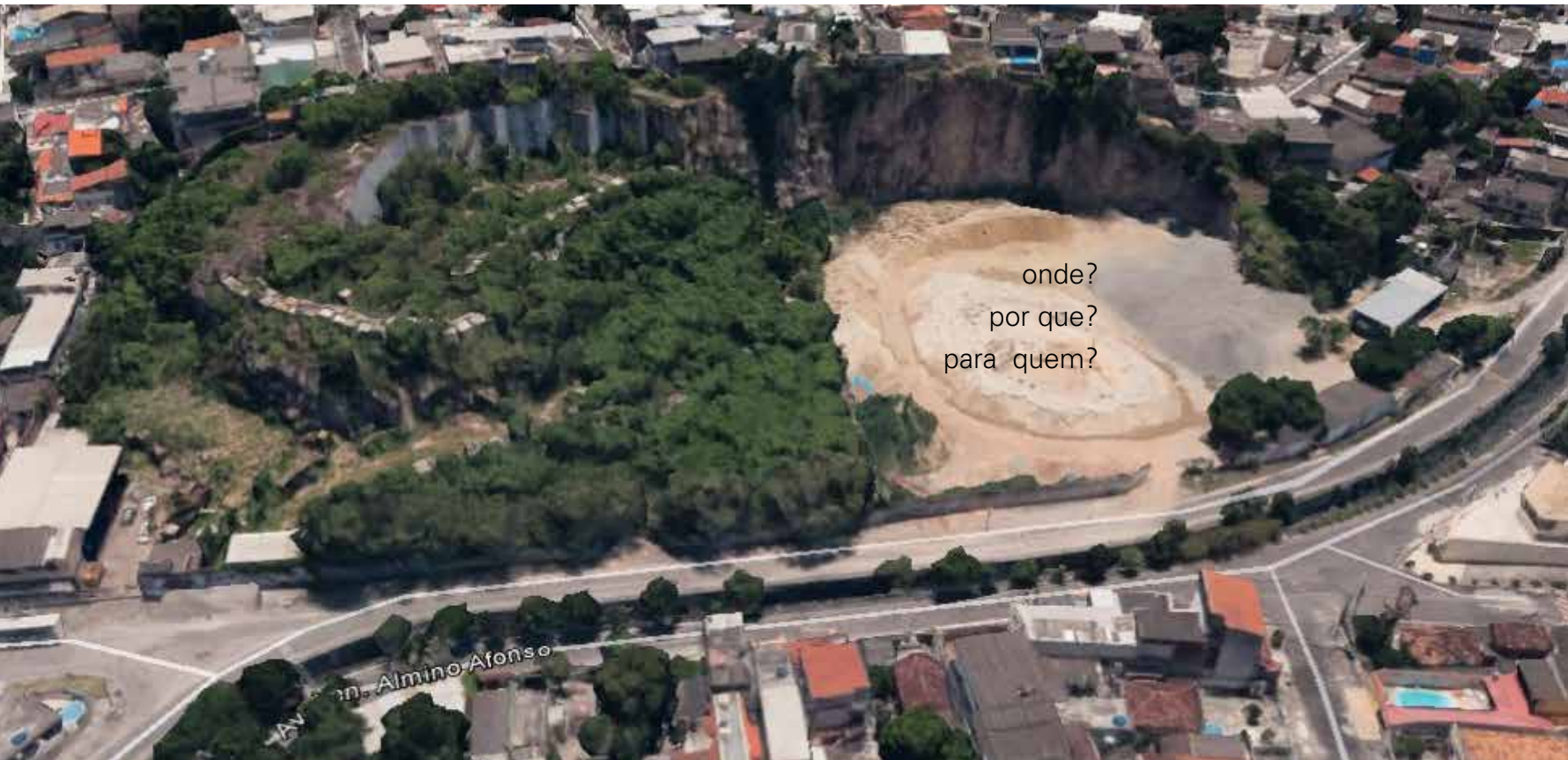
F02 – Vista aérea da área das pedreiras. Fonte: Imagem do Google Earth
