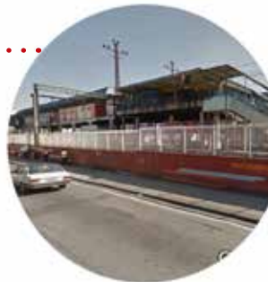
F07 - Estação Ferroviária e seus acessos.
