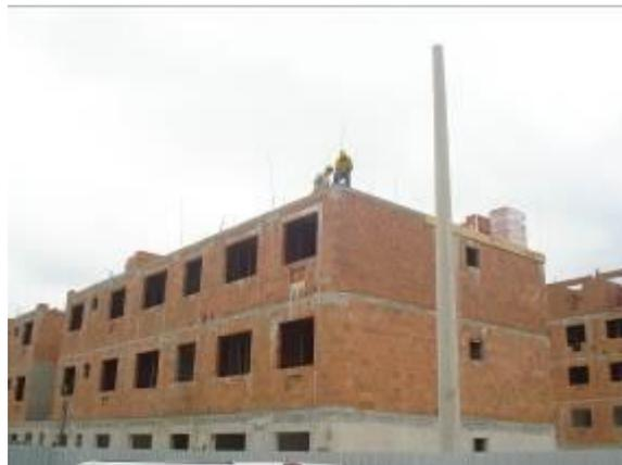
Figura 7: Um prédio construído com paredes de concreto e o outro com alvenaria de tijolos de barro autoportantes. Fonte: Laboratório Habitação + Forma Urbana.
